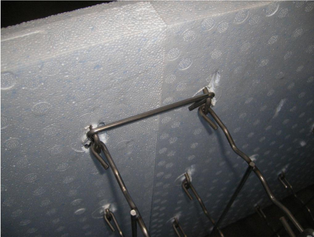
**Image 2.13.b – Installation d'un crochet de joint.**
